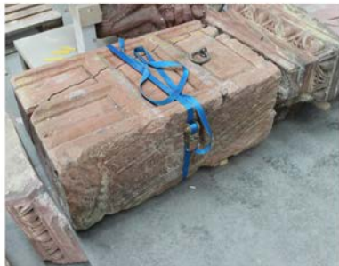
Abtransport und Aufbereitung im Werk der Bamberger Natursteine.
